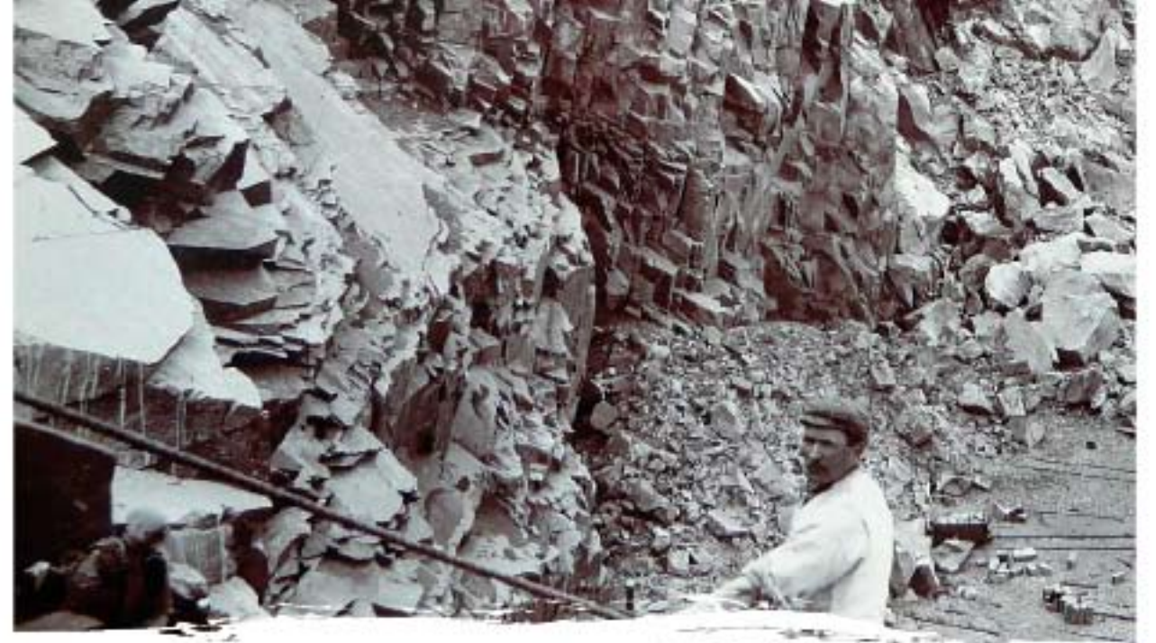
▲ Tyllwr yn gollwng ei hun i lawr y graig Driller about to lower himself down the rockface
